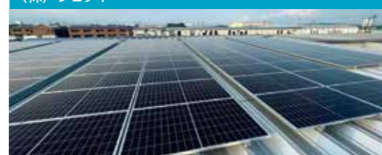
太陽光パネルの設置 (株)ジョッキ
