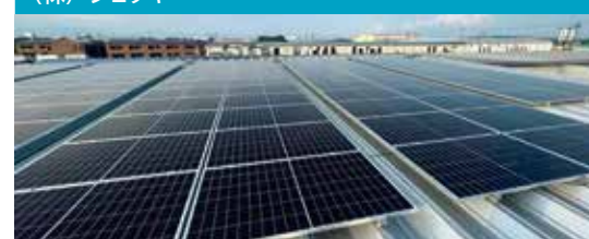
太陽光パネルの設置 (株)ジョッキ
